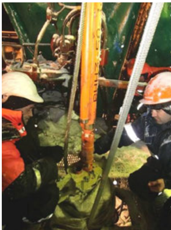
Рис. 12. Монтаж установки ОРЭ
