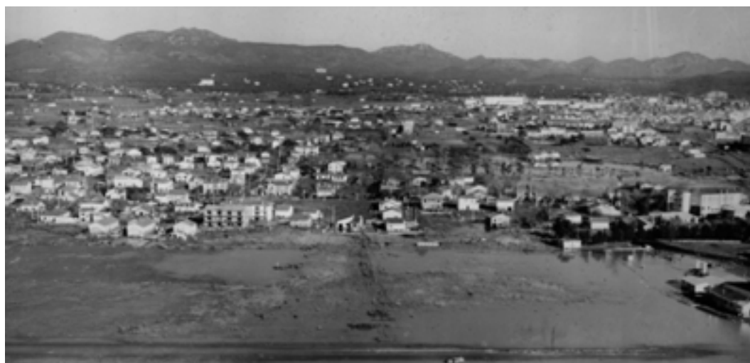
Рис. 4. Последствия разрушения плотины Мальпасе
